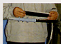
5. 分別於前端 / 末端 纏繞 #70 號矽橡膠 帶和自融防水膠帶
